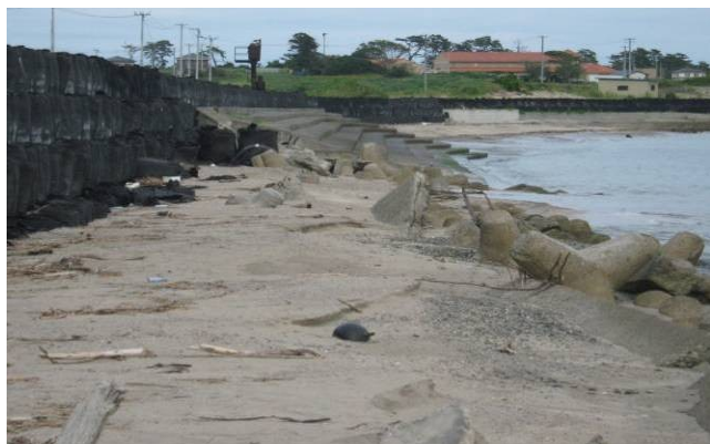
写真 19 現在の大谷海岸の様子
